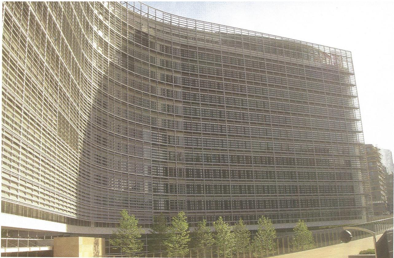
Ci-dessus, plan général d'une façade, ventelles ouvertes en position protection solaire
